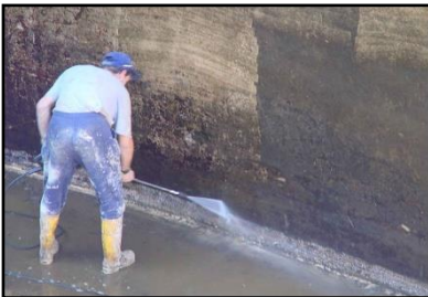
Preparación en muro de contención
